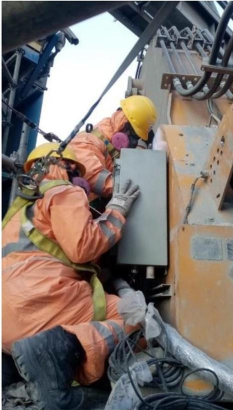
**Figura 1.** Montaje de nuevos tableros y módulos electrónicos.
