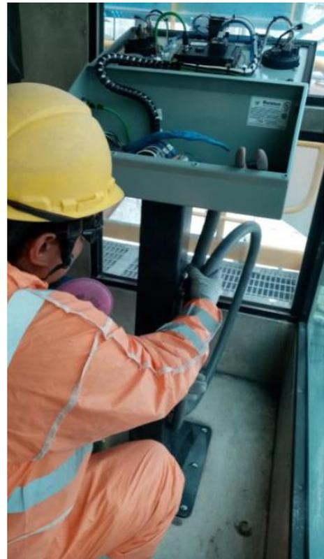
**Figura 2.** Actualización de joystick en sala de control en mina.
