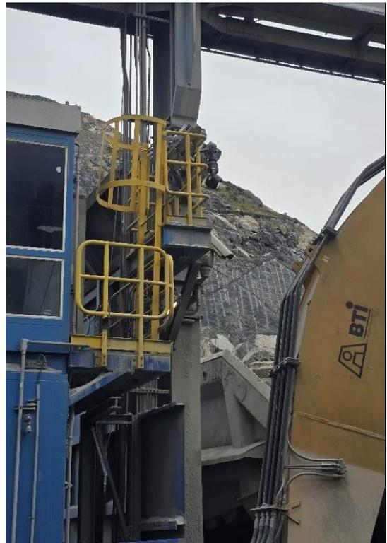
**Figura 5. Escaleras estructurales para acceso a las cámaras y luminarias**
